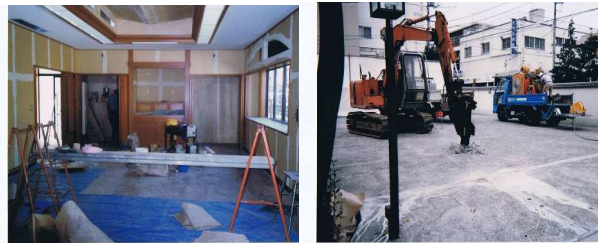
(工事中の写真です。)
